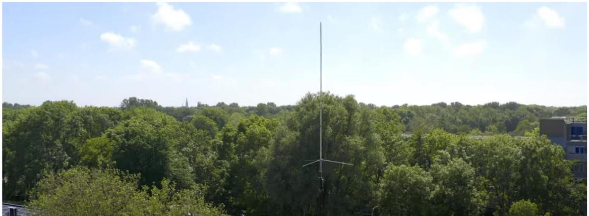
Las antenas verticales, especialmente para HF, donde se utiliza tierra separada o un sistema radial, tendrán un conjunto de adaptación en el punto de alimentación base para acomodar el desajuste, ya que normalmente se alimentan con un alimentador coaxial de  $50\Omega$ . Este arreglo de adaptación normalmente consiste en una bobina de derivación que da la transformación de impedancia requerida. La impedancia de esta antena suele ser de unos  $20\Omega$ .
